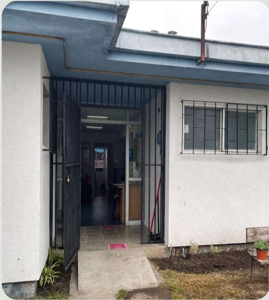
MEJORAMIENTO SALA CUNA
